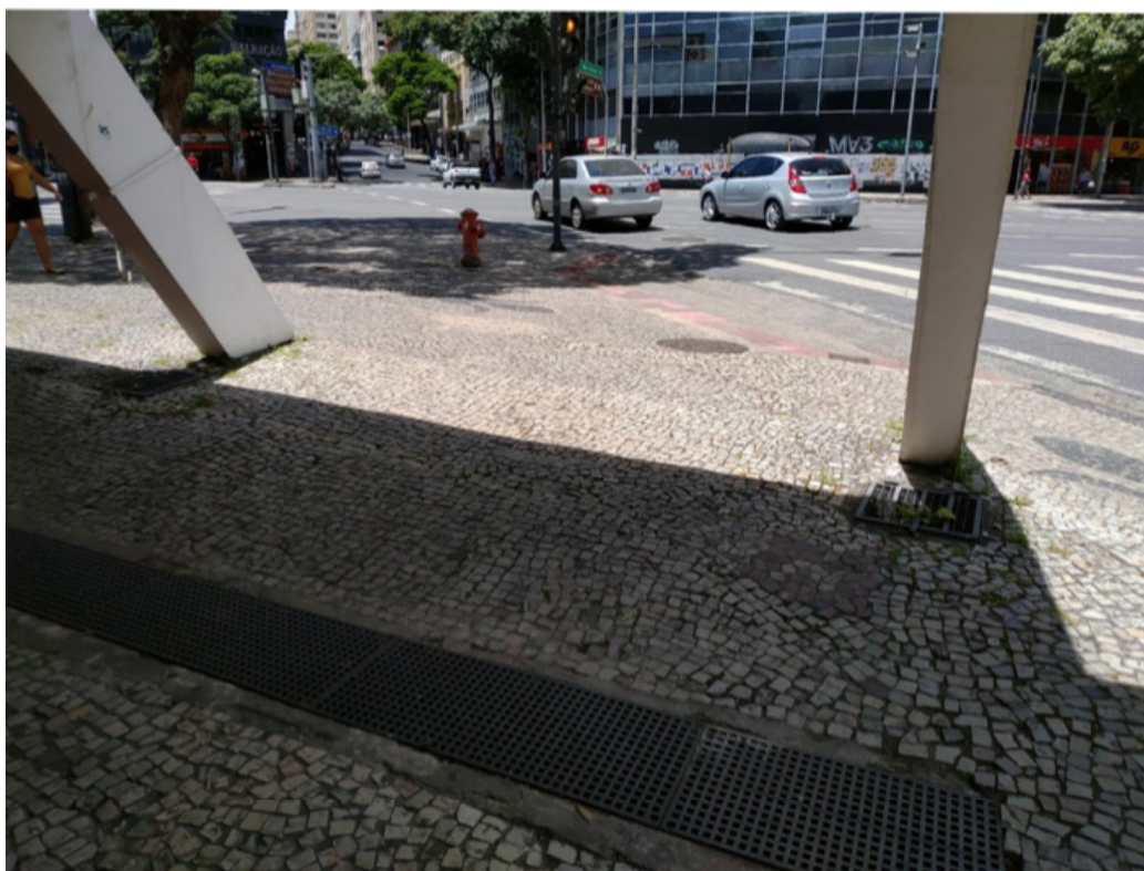
Pilar destacado pelo círculo verde e piso direcional e cor de rosa. Grelha de drenagem interrompe a faixa de piso liso.
