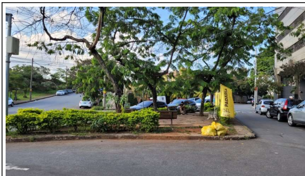
Foto 01: Não há rebaixamento adequado da calçada para acesso à praça
