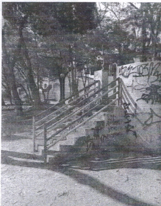
Escadas em desacordo com a NBR 9050
