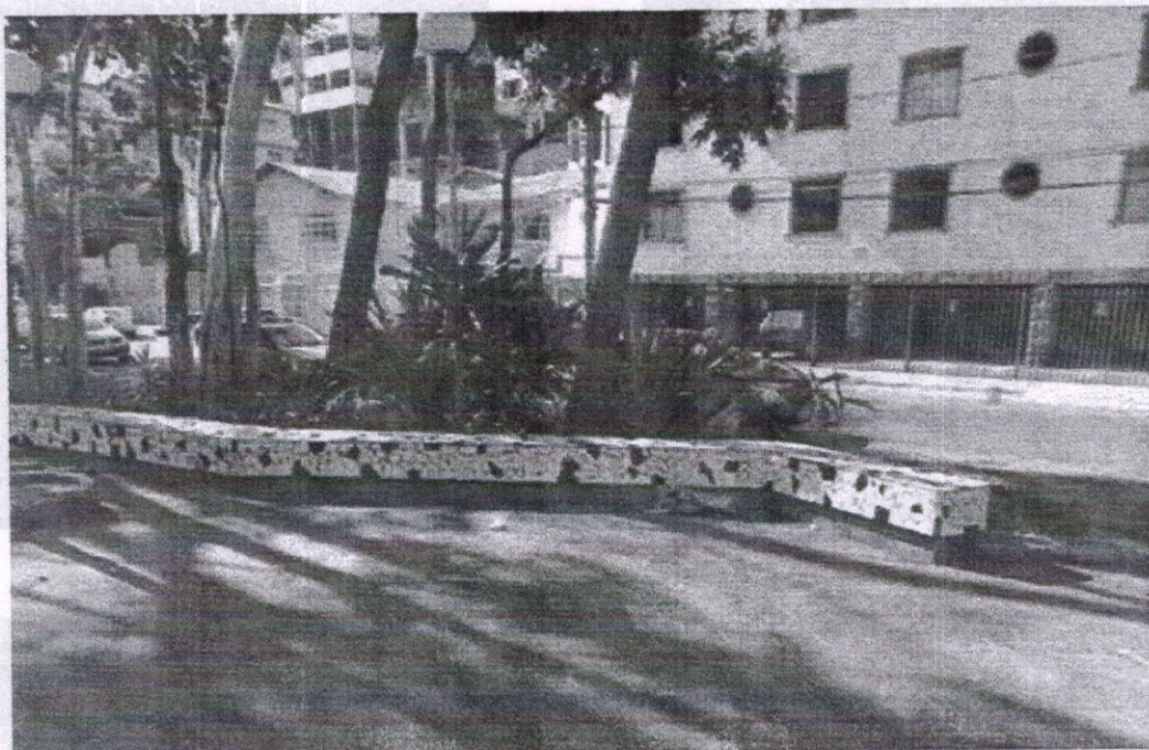
Mobiliário contínuo impedindo a aproximação de pessoas com mobilidade reduzida que usam cadeiras de rodas
