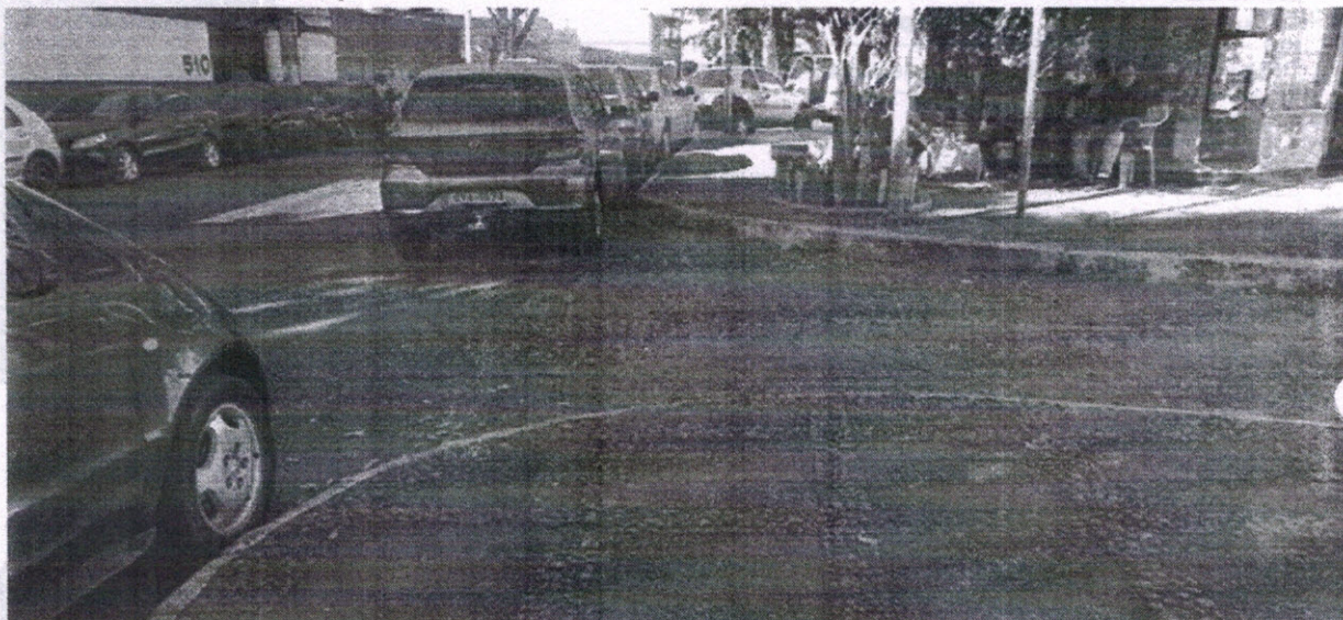
Ausência de rebaixo no passeio
