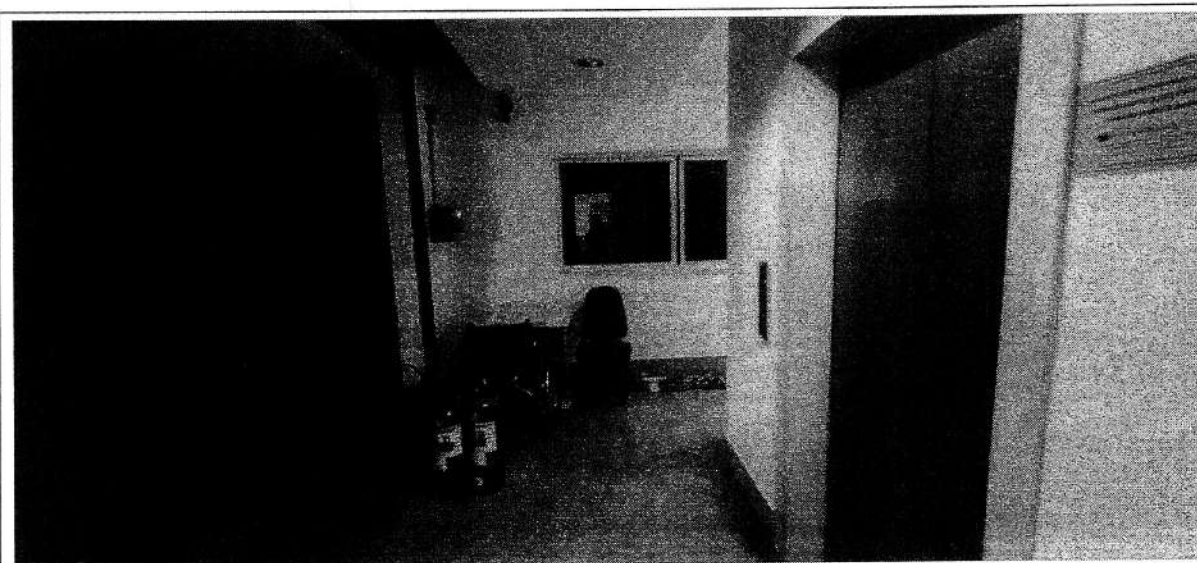
Foto 09: Elevador secundário – não possui sinalização tátil de alerta. À esquerda, espaço para carga e descarga. À direita, circulação de acesso à sala de restauro
