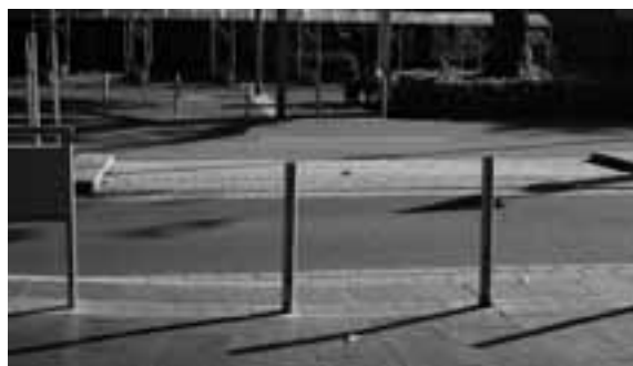
Bolardos distanciados que permiten la circulación peatonal inclusive en silla de ruedas e impiden el acceso de vehículos.
