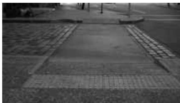
El pavimento en el cruce debe facilitar el desplazamiento a todas las personas. En este caso los adoquines se reemplazan por un pavimento liso.
