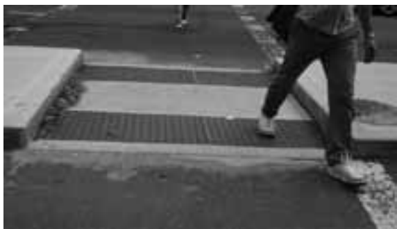
Los bandejones centrales también deben indicar con franjas de advertencia la situación de riesgo en el cruce.
