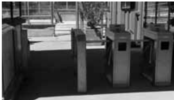
En accesos donde es necesaria la instalación de torniquetes es imprescindible contar con un paso libre de obstáculos para sillas de rueda.
