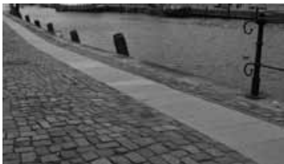
Itinerario peatonal que cambia a un material más apto para el desplazamiento de personas con movilidad reducida.
