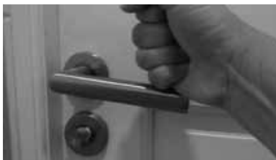
En cerraduras se recomiendan las de tipo manilla. Se pueden accionar con el puño o codo, facilitando la apertura en diferentes condiciones de uso.
