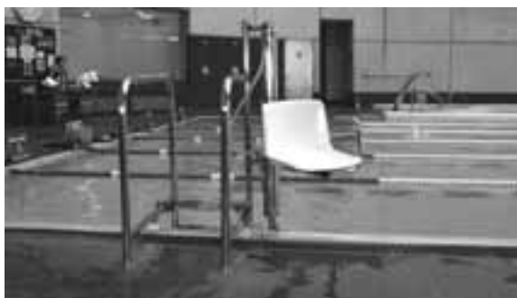
Elevador hidráulico para acceder a una piscina.
