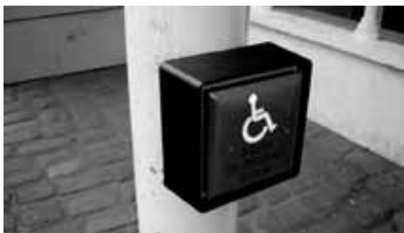
En puertas muy pesadas para abrir se utilizan aperturas de puertas automáticas que facilitan el acceso a personas con discapacidad.
