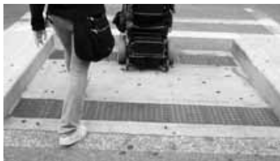
Los bandejones centrales deben mantener el mismo ancho del cruce demarcado y el nivel de la calzada.
