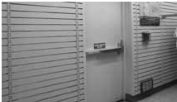
Salida de emergencia con dispositivo antipánico, buena señalización y botón de activación de alarma de incendio a altura adecuada.
