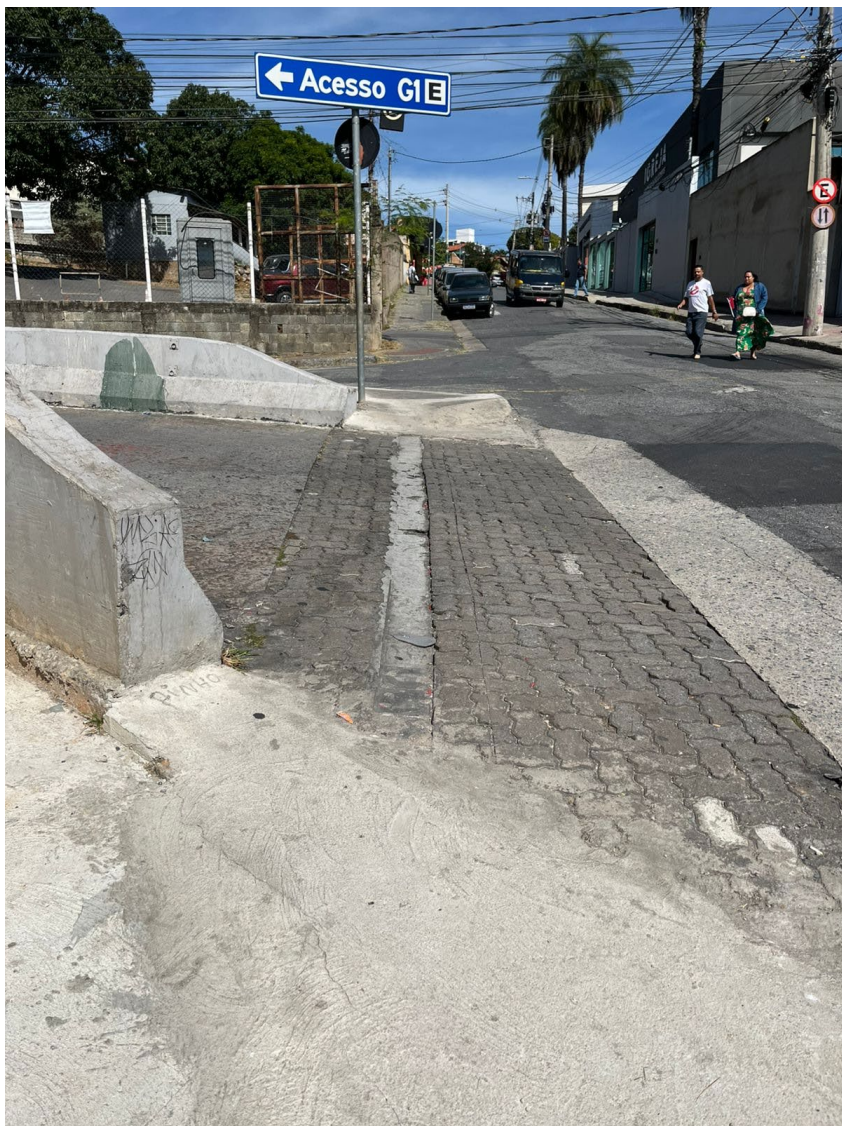
Foto 08: Acesso ao estacionamento pela Rua Jaboticabeiras
