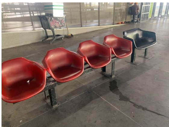
Foto 3: Assentos Plataforma Norte
