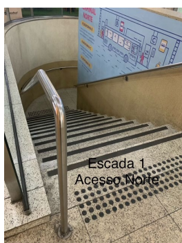
Foto 8: Escada 1 de acesso à Plataforma Norte
