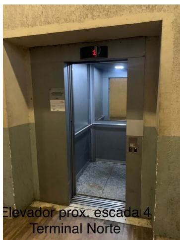
Foto 10: Elevador de acesso à Plataforma Norte
