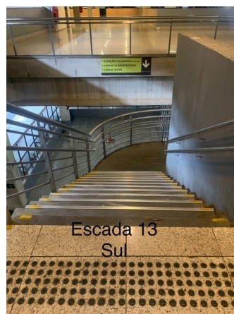
Foto 13: Escada 13 de acesso à Plataforma Sul
