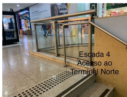
Foto 9: Escada 4 de acesso à Plataforma Norte
