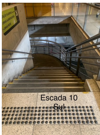
Foto 12: Escada 10 de acesso à Plataforma Sul
