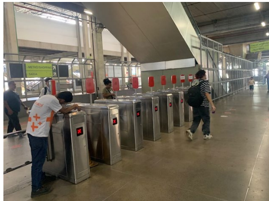
Foto 2: Catraca acessível Plataforma Sul
