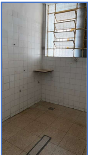
Sanitário 5 - 2º Pavimento Fonte: do autor
