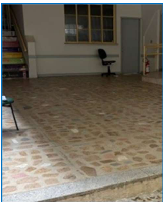
Janela da Recepção Fonte: do autor
