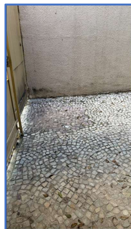
Rampa 1 no acesso ao lote
