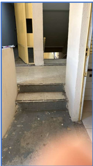
Degraus isolados - Escada 4: Acesso ao Pátio e Vestiários Fonte: do autor
