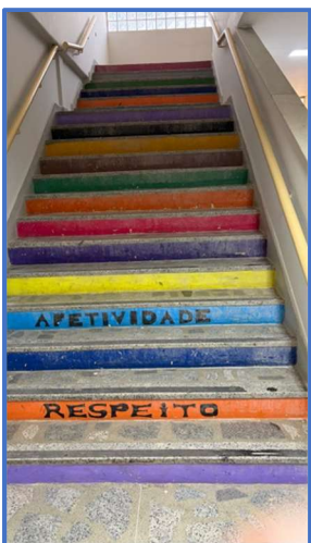
Escada 2 - Acesso do 2º ao 3º Pavimentos Fonte: do autor
