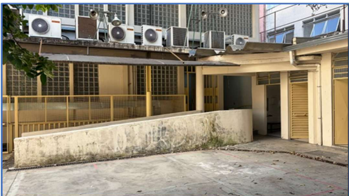
Rampa 12 - Acesso ao pátio Fonte: do autor
