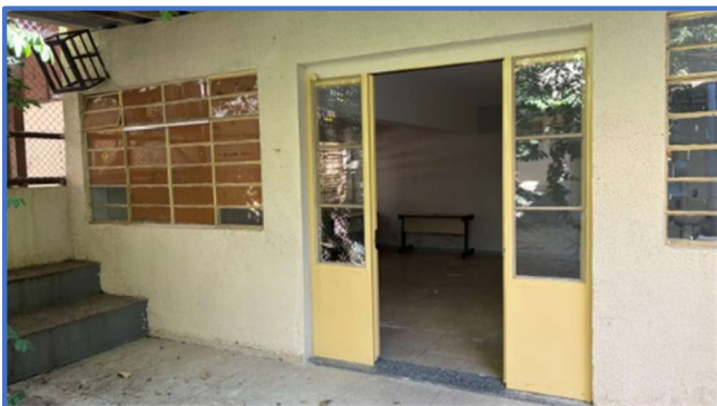
Soleira de porta - Refeitório
