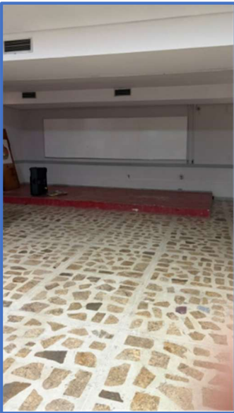
Degrau isolado: Acesso ao palco Fonte: do autor
