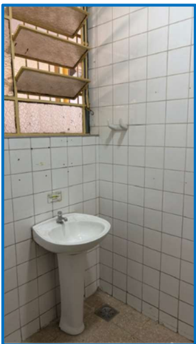
Comando de abertura de janela fora da faixa de alcance manual Fonte: do autor
