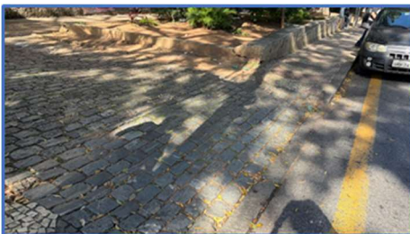
Guia rebaixada para veículos Fonte: do autor
