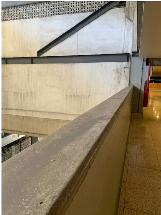
Foto 1: Local sugerido para o patamar de início da descida da rampa - Nível G1
