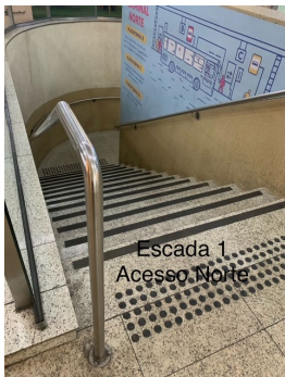
Foto 8: Escada 1 de acesso à Plataforma Norte
