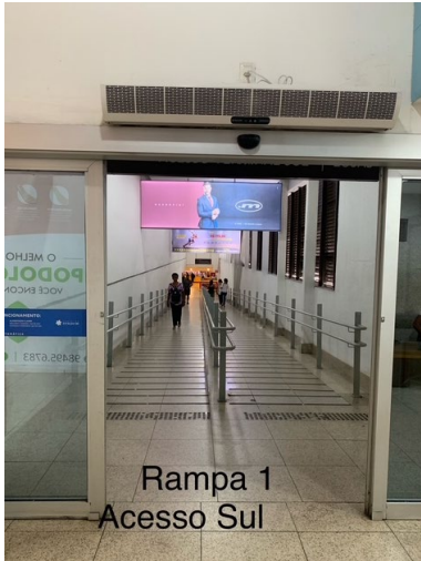
Fotos 18: porta envidraçada
