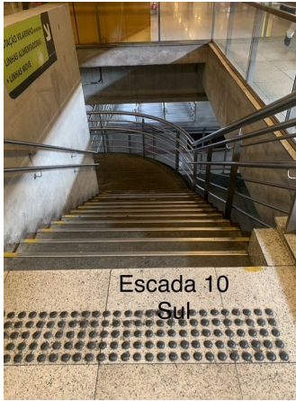
Foto 12: Escada 10 de acesso à Plataforma Sul
