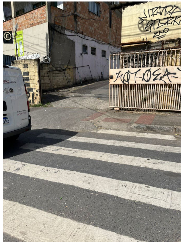
Foto 3: Travessia na interseção da Av. Vilarinho com a Rua Jaboticabeiras
