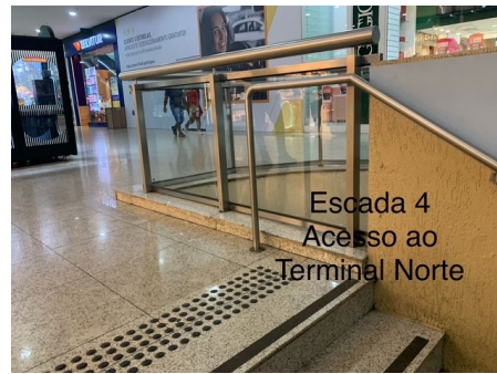
Foto 9: Escada 4 de acesso à Plataforma Norte
