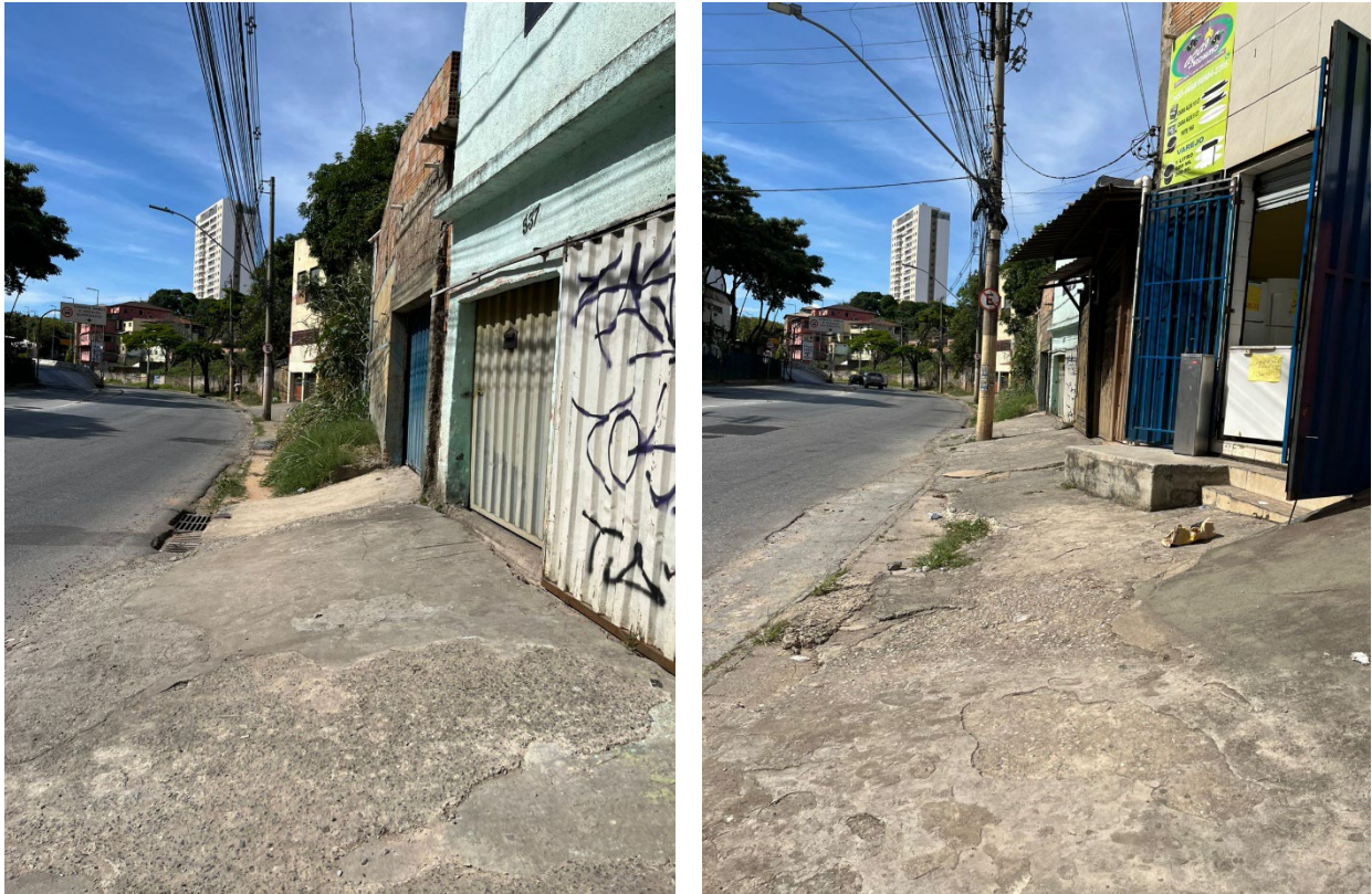
Fotos 10 e 11: Av. Vilarinho entre Rua Jaboticabeiras e Av. Cristiano Machado
