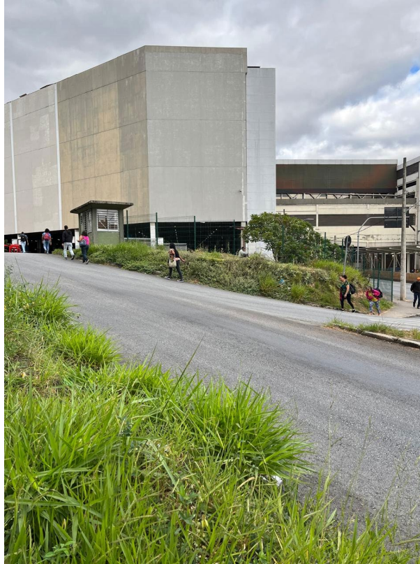
Foto 07: Acesso à Estação Vilarinho pela Rua Malibu e pela Av. Vilarinho
